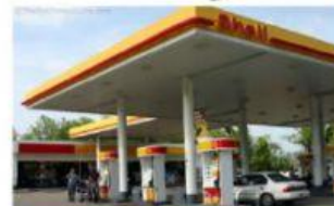
ESTACIÓN DE GASOLINA
