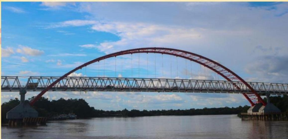
Jembatan Kahayan berada di Kota Palangka Raya, Kalimantan Tengah. Jembatan ini memiliki panjang 640 meter dan lebar 9 meter, terdiri dari 12 bentang dengan bentang khusus sepanjang 150 meter pada alur pelayaran. Jembatan ini pertama kali dibangun pada tahun 1995 dan selesai dibangun pada tahun 2001, serta diresmikan oleh Presiden ke-5 RI **Megawati Soekarno putri** pada tanggal 13 Januari 2002.
