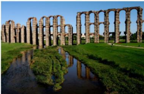
Acueducto de los Milagros (Mérida)
