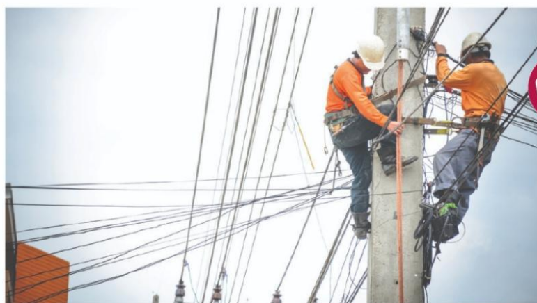
Fig. 28. Electricieni de rețele electrice
