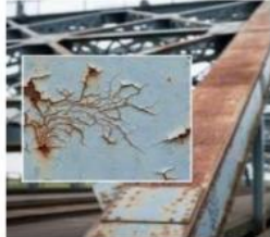
Gambar: Contoh jembatan besi yang dicat, namun mengalami kerusakan cat dan korosi.
