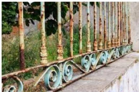
Pernahkah kamu memperhatikan paku, pagar, atau bagian kendaraan yang dibiarkan di udara terbuka dalam waktu lama? Awalnya logam tersebut tampak mengilap dan kuat, tetapi lama-kelamaan berubah warna menjadi cokelat kemerahan dan mudah rapuh. Fenomena ini disebut karat.
