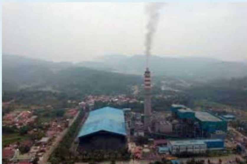
Gambar 1. Pembangkit Listrik Tenaga Uap
