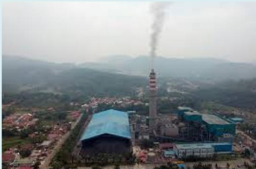
Gambar 1. Pembangkit Listrik Tenaga Uap
