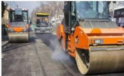
Gambar pembangunan jalan menggunakan aspal atau beton
