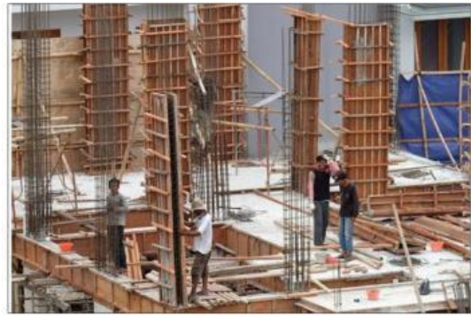
Gambar 1.1 Pengerjaan kolom beton bertulang.
