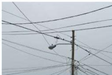
Gambar 4.1 Pemuaian Pada Kabel
