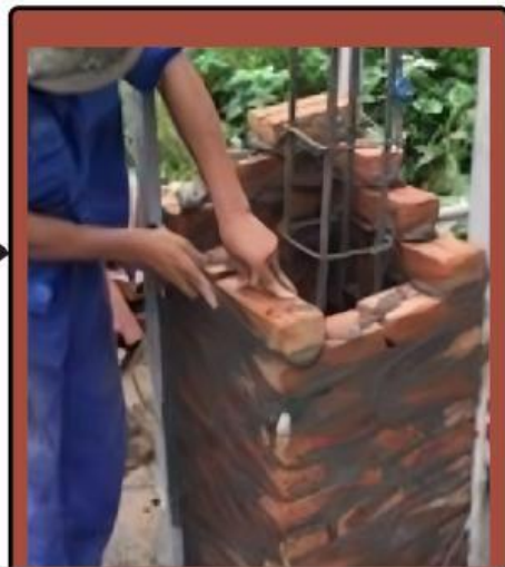
Batu bata disusun membentuk seperti pada gambar
