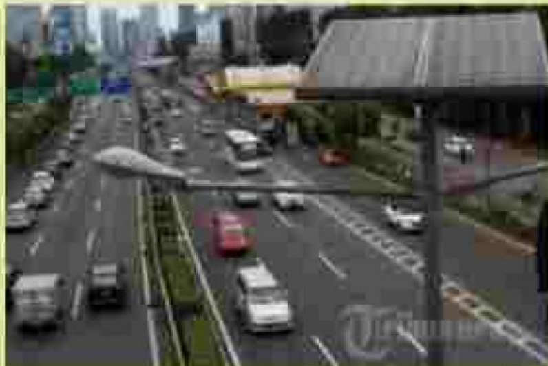
Lampu penerangan jalan menggunakan tenaga surya
