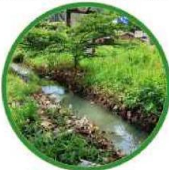
Gambar 1. genangan air di selokan Sumber: dokumentasi pribadi
