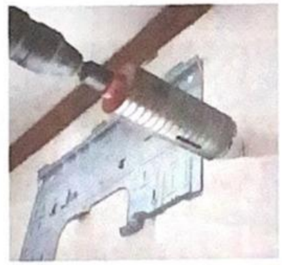
ติดตั้งแผ่นแขวนเครื่องพร้อมเจาะรูท่อออก
