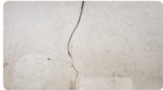
Gambar 2. Bangunan retak
