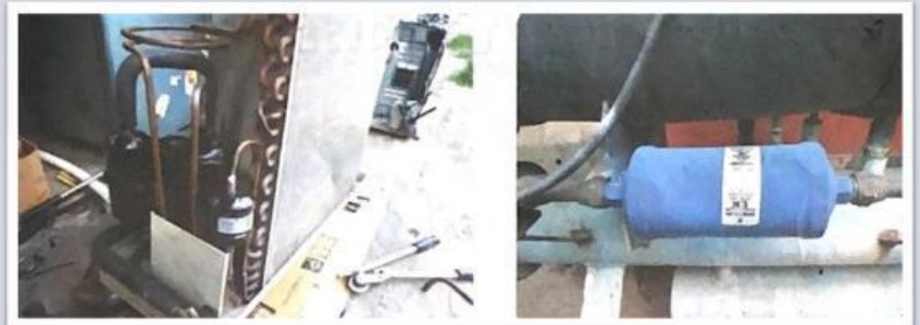
การติดตั้งฟิวเตอร์ไดรเออร์
