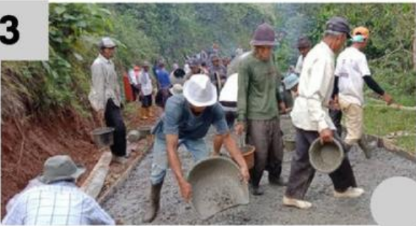
memperbaiki jalan yang rusak
