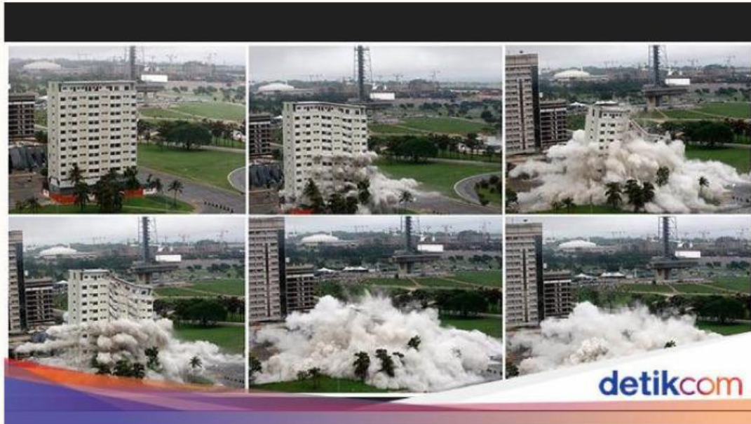
Gambar 1. Perobohan Gedung Dengan Peledakan Sumber : detiknews.com
