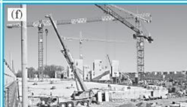
Tapak pembinaan Construction area
