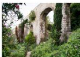
ACUEDUCTO ROMANO DE SANTA LUCÍA
