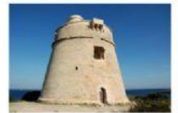
TORRE DES CARREGADOR
