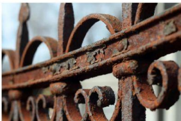
Gambar 1. Perkaratan Pada Pagar Besi
