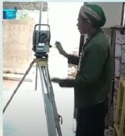
Gambar 3. Total Station Sumber : dokumen pribadi
