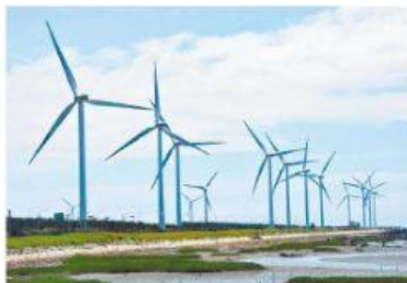
彰濱工業區陸地發電機
