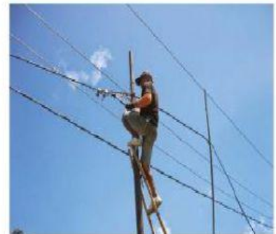
Gambar 8. Pemasangan Kabel Listrik
