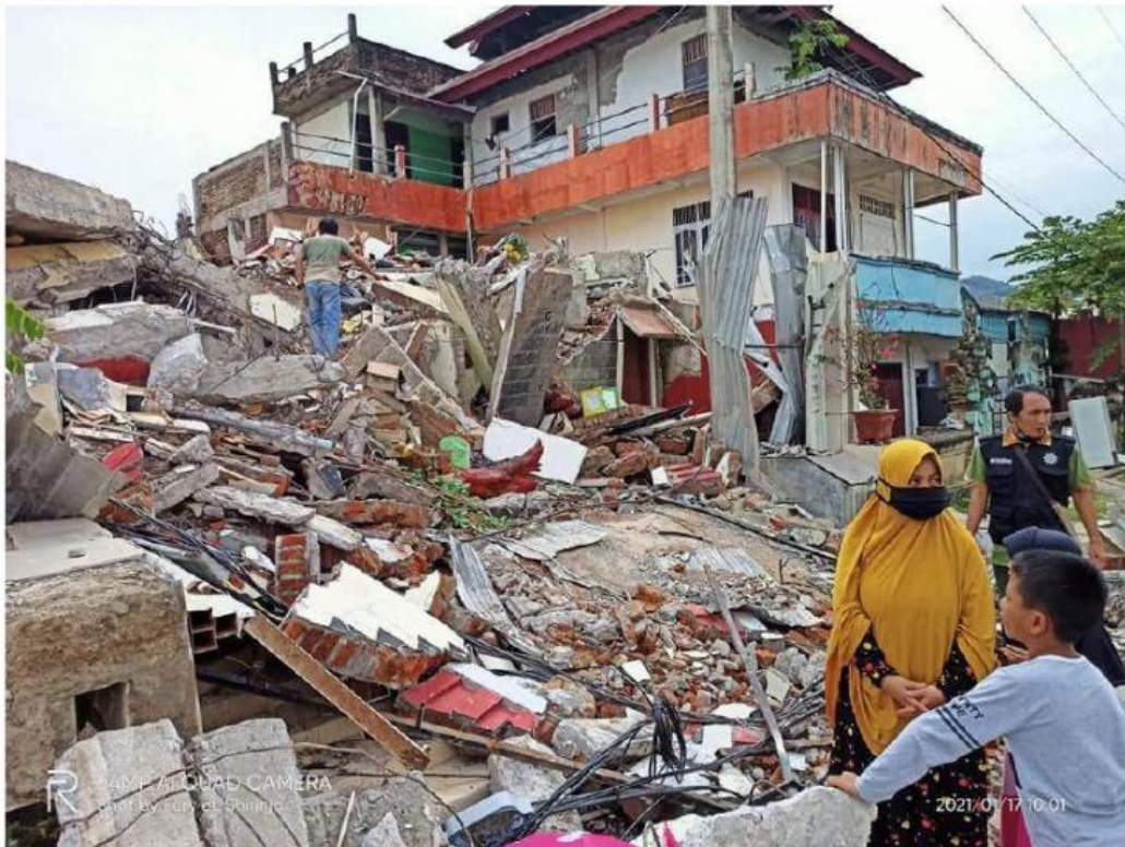
RUSAK BERAT : Salah satu gedung di Sulbar yang rusak berat disebabkan gempa bumi 6,2 skala Richter
