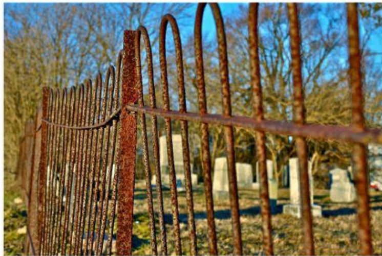
A rusted gate (valla oxidada)
