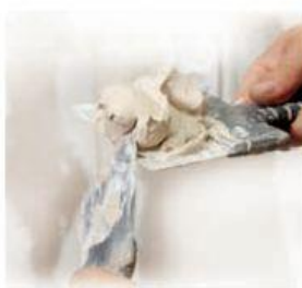
Produkcja cementu i zapraw murarskich
