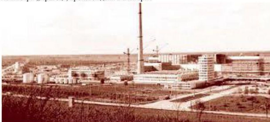
Първи блок на АЕЦ „Козлодуй“, построен през 1974г.
