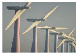
Pembangkit Listrik Tenaga Bayu (PLTB)
