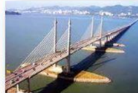
Jambatan Pulau Pinang
