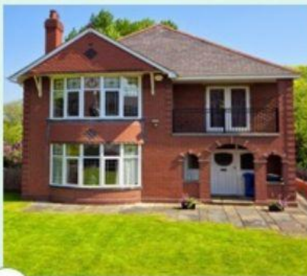
Casa de ladrillo
