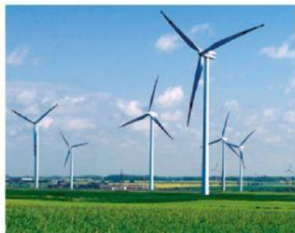
Pojedyncze turbiny w elektrowniach wiatrowych w Polsce mają zwykle moc od 2 do 3 MW.
