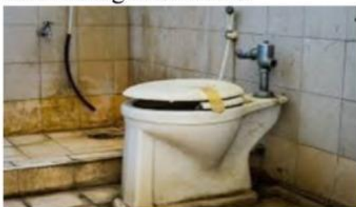
Gambar 2. Kerak Membandel pada Toilet
