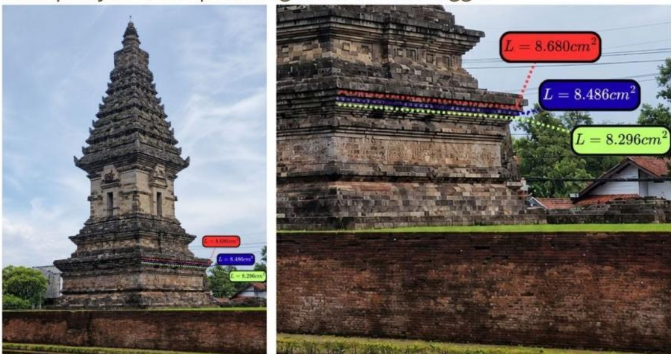
Gambar 7. Luas Tiga Lapisan pada Bagian Atas Kaki Candi Jawi
