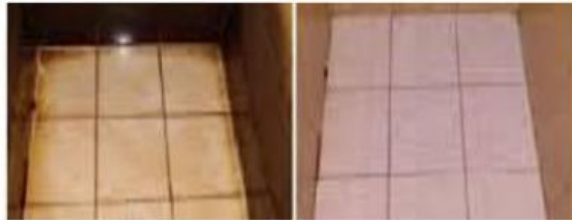
Gambar 1. Perbedaan porselen setelah dibersihkan menggunakan (a) Cairan pembersih porselen yang diencerkan dengan air dan (b) Cairan pembersih porselen tanpa diencerkan dengan air
