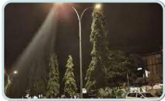
Gambar 2. Lampu hias yang dililitkan di tiang jalanan padam semua
