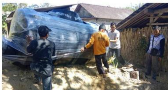
Figure 1. Proses pemasangan biogas digester oleh Kelompok Tani Hutan (KTH) Sumber: Penny.co.id
