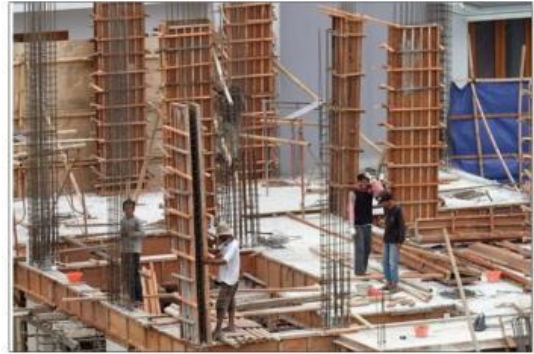
Gambar 1.1 Pengerjaan kolom beton bertulang.
