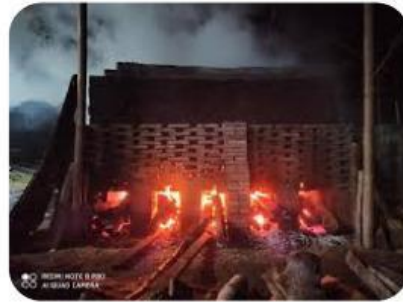
Gambar 3.1 Pembakaran Batu Bata
