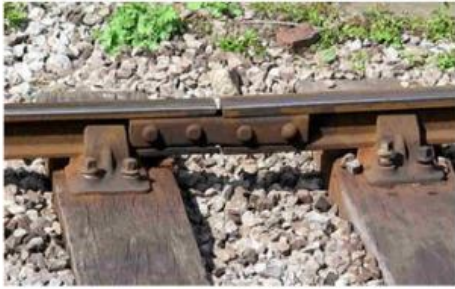
Gambar 1. Sambungan rel kereta api dengan celah di antara sambungannya
