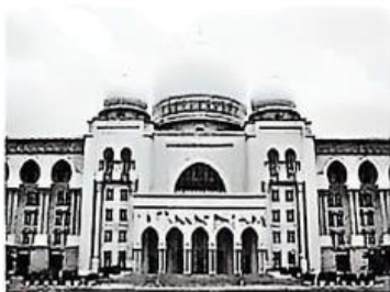
Istana Kehakiman di Putrajaya
