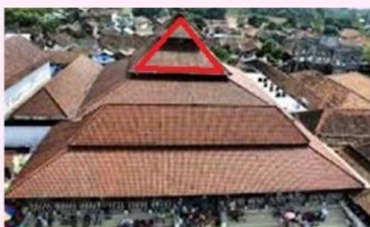
Masjid Agung Banten merupakan salah satu masjid tertua yang ada di Indonesia. Masjid Agung Banten memiliki atap lima tingkat berbentuk bujur sangkar setinggi 30 m, berupa atap tumpang yang tersusun semakin ke atas makin mengecil dan yang paling atas berbentuk limas yang disebut kubah dan setiap sisinya berbentuk segitiga sama sisi. Atap ini menggunakan genteng dengan memolo pada puncaknya, dimana tinggi memolo tersebut adalah 1,2 meter terbuat dari tanah liat.
