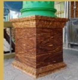
Penyangga tiang yang akan di renovasi berisi batubata, semen dan kerangka besi
