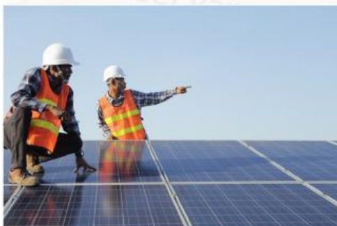
Operaris instal·lant plaques solars
