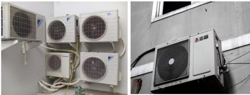
Gambar 5.5 Kompresor dan kondensor AC mengeluarkan hawa panas
