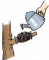
d) Siramlah bagian yang telah ditutup agar tetap lembap.
