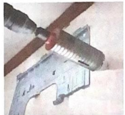
ติดตั้งแผ่นแขนเครื่องพร้อมเจาะรูท่อออก
