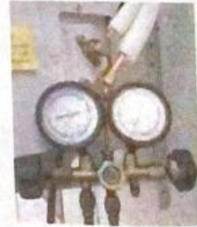
ทำสุญญากาศและวัดความดัน
