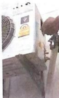
บานท่อน้ำเย็นเข้ากับวาล์ว
